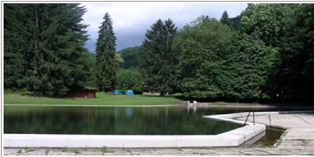
Slika 5. Bazen na Strmcu
