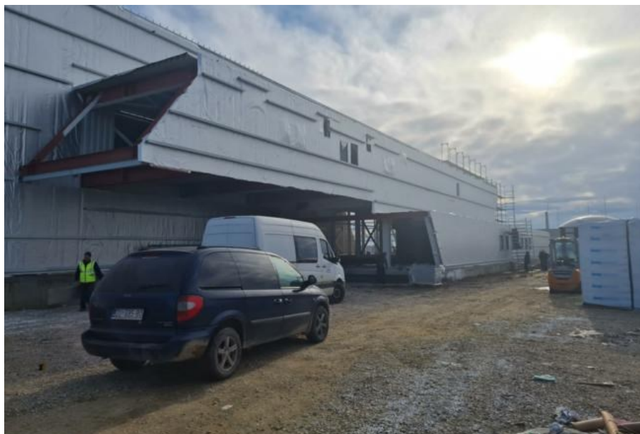
Slika 17. Gradilište Agrotehnološkog centra u Cerni
