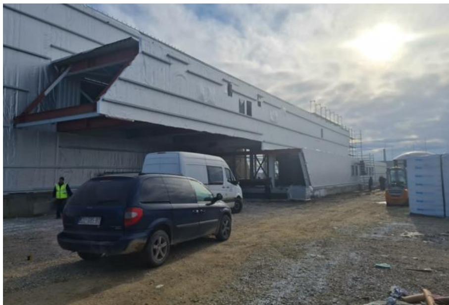
Slika 17. Gradilište Agrotehnološkog centra u Cerni
