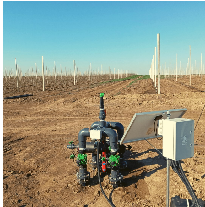
Slika 9. Sustav za pametno navodnjavanje Smart Watering
